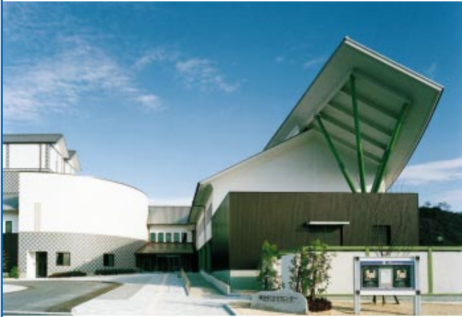
建部町文化センター(建物は高瀬舟と蔵と市場をイメージ)
