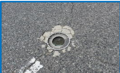
交差点のグランドライトの破損
