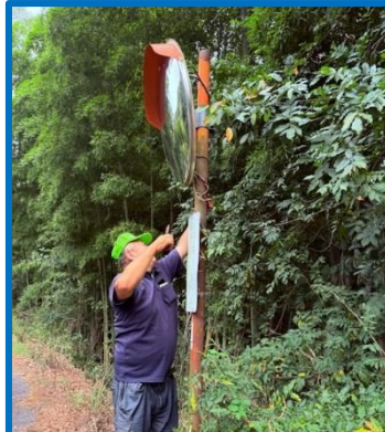
ツルの絡まりの撤去
